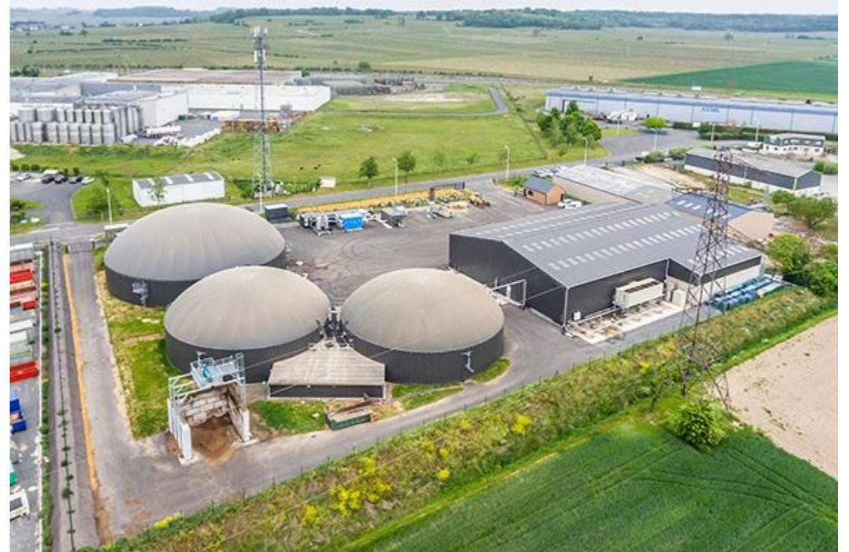
SAS Saumur Biométhane (200 Nm 3 /h) – Bellevigne-les-Châteaux
